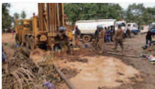
博凱地區的水井開鑿工程
